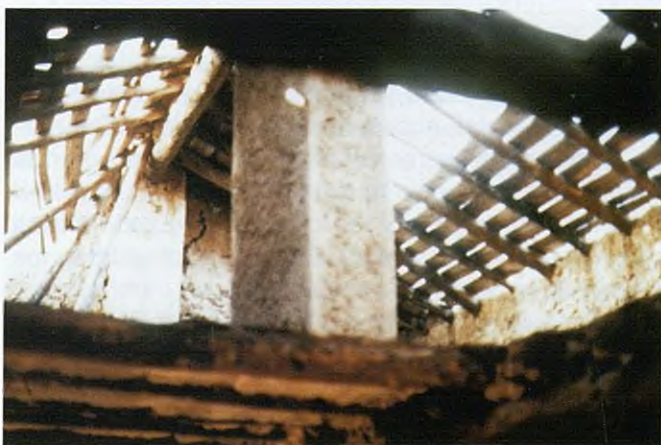
Foto 34. Detalle del entramado interno de una tinada en El Ferrario.
