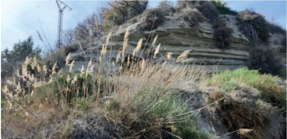
Lám. 7. Una cueva de salitre, junto al edificio que fue la fábrica. Foto: M. Laguna.
