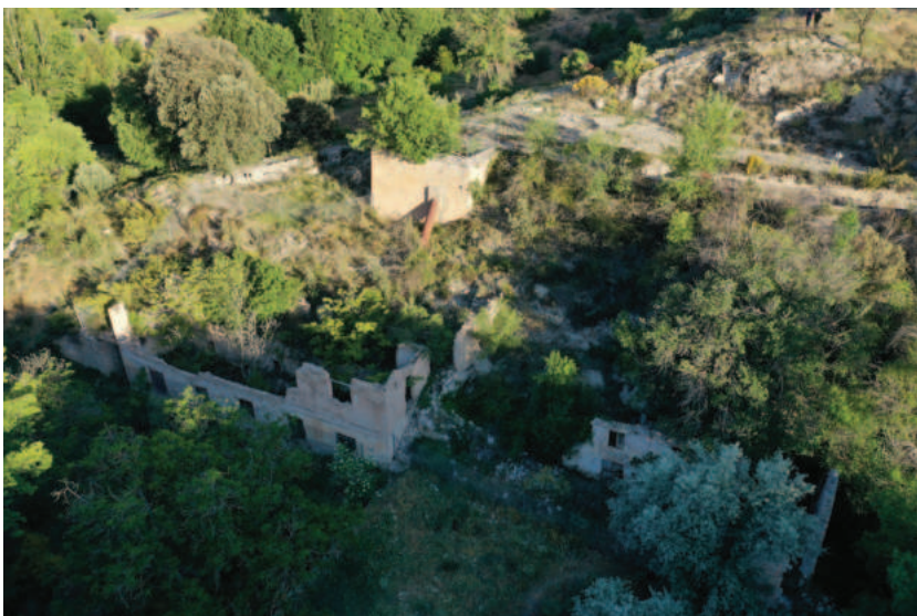
Láms. 24 y 25. Ruinas de la segunda fábrica hidroeléctrica de Claudio Penalva Navarro (2024). Fotos: Jesús Fernández García y Juan Manuel García Fernández.
