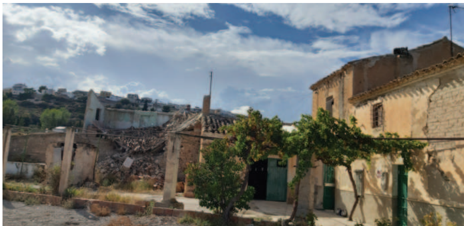
Lám. 8. La fábrica de salitre construida por los Grisolia en 1846. Foto: M. Laguna.
